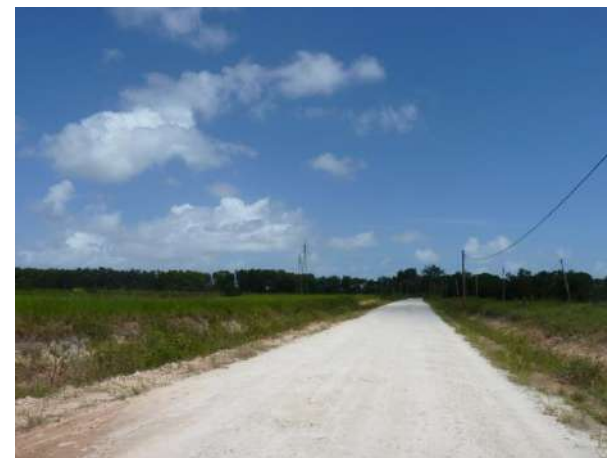
Figure 67: Début du tronçon 15
